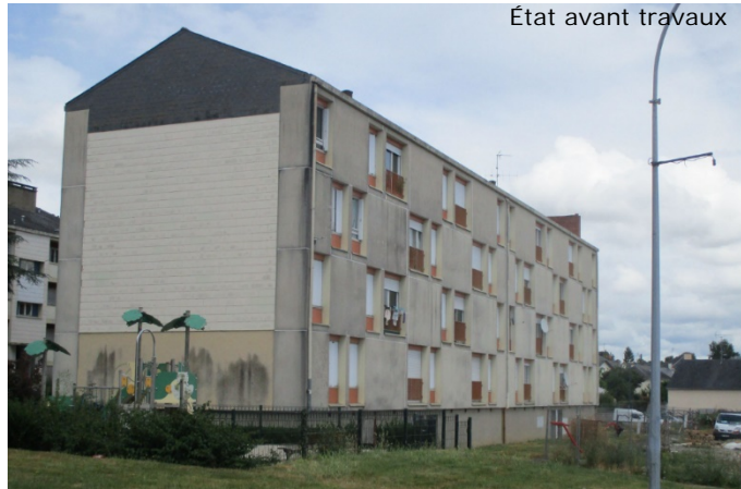
État avant travaux
